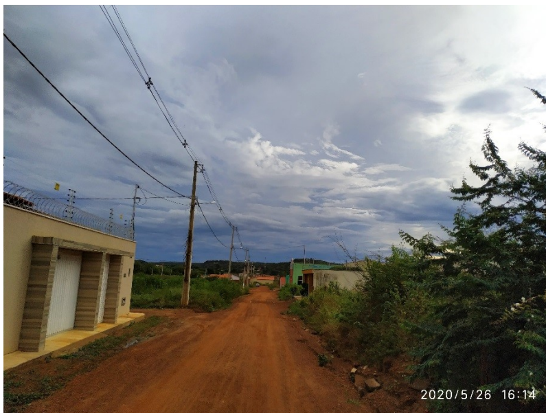
Foto nº 09: Rua Zé Brandão Trecho II
