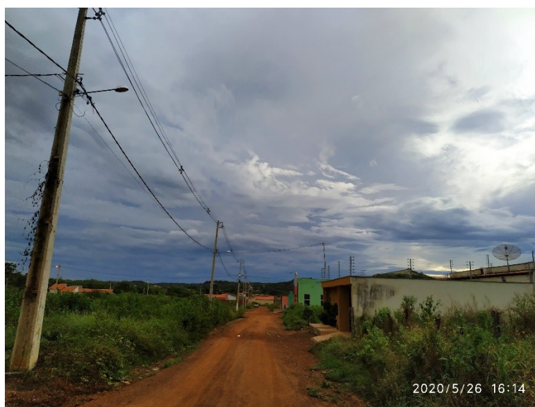
Foto nº 10: Rua Zé Brandão Trecho II
