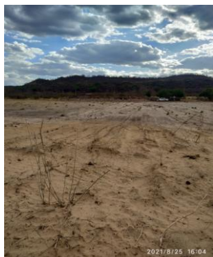
FOTO 05 - TERRENO PARA CONSTRUÇÃO DA USINA SOLAR FOTOVOLTAICA
