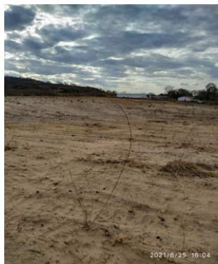
FOTO 03 - TERRENO PARA CONSTRUÇÃO DA USINA SOLAR FOTOVOLTAICA
