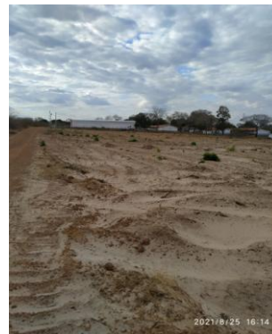
FOTO 04 - TERRENO PARA CONSTRUÇÃO DA USINA SOLAR FOTOVOLTAICA
