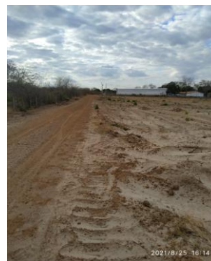
FOTO 06 - TERRENO PARA CONSTRUÇÃO DA USINA SOLAR FOTOVOLTAICA
