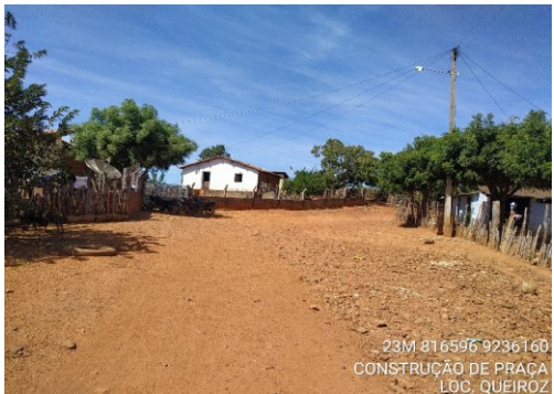
Foto Nº 03 - Construção de Praça Pública
