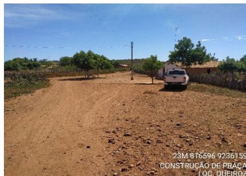
Foto Nº 02 - Construção de Praça Pública
