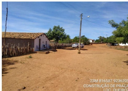
Foto Nº 08 - Construção de Praça Pública
