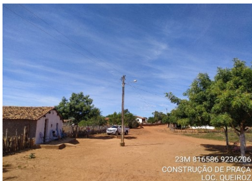
Foto Nº 07 - Construção de Praça Pública
