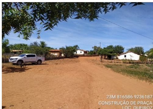
Foto Nº 05 - Construção de Praça Pública
