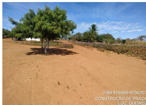
Foto Nº 10 - Construção de Praça Pública
