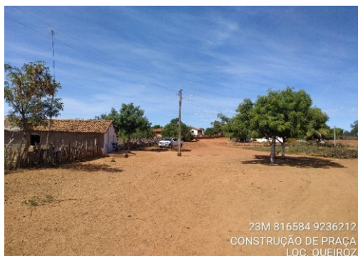
Foto Nº 09 - Construção de Praça Pública
