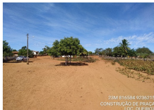
Foto Nº 12 - Construção de Praça Pública
