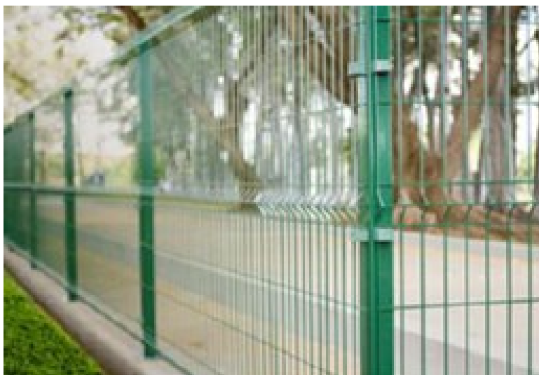
Alambrado em perfis metálicos retangulares com gradil metálico
