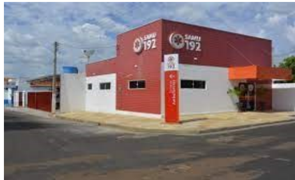
Foto Nº 02 - Via a ser sinalizada
