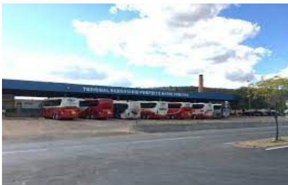
Foto Nº 03 - Via a ser sinalizada
