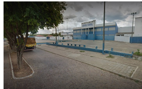
Foto Nº 06 - Via a ser sinalizada
