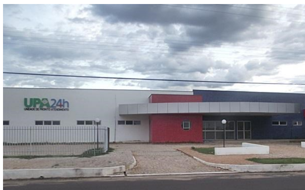
Foto Nº 05 - Via a ser sinalizada
