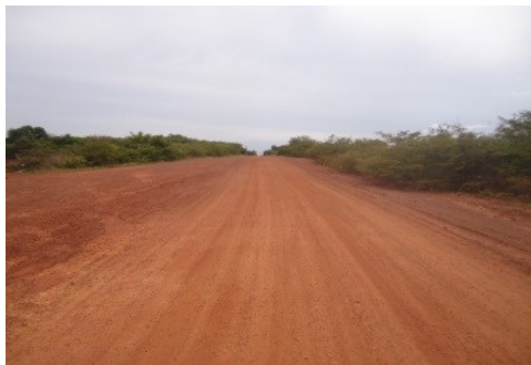
TRECHO DA PAVIMENTAÇÃO
