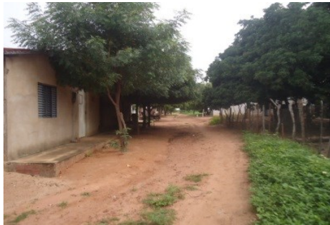
TRECHO DA PAVIMENTAÇÃO
