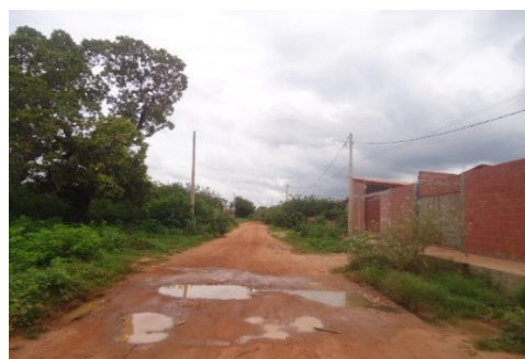
TRECHO DA PAVIMENTAÇÃO
