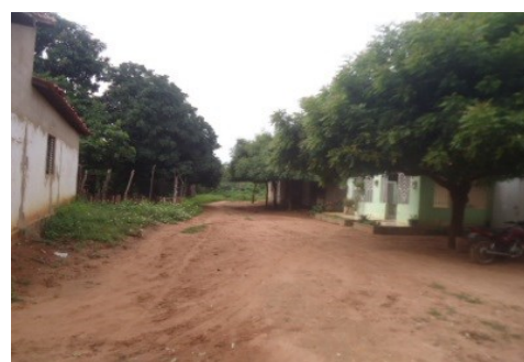
TRECHO DA PAVIMENTAÇÃO
