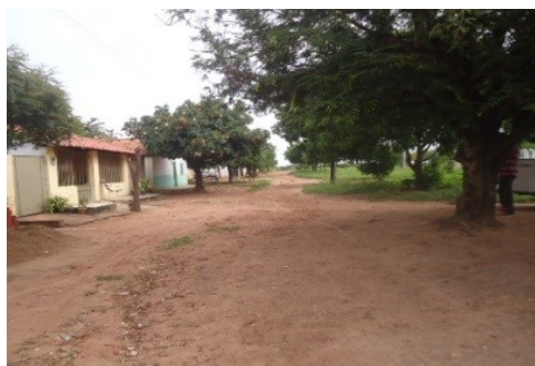
TRECHO DA PAVIMENTAÇÃO
