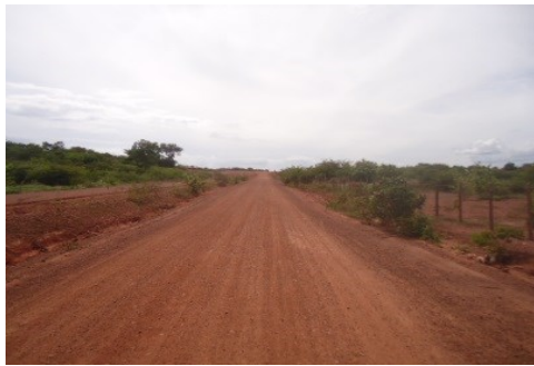
TRECHO DA PAVIMENTAÇÃO
