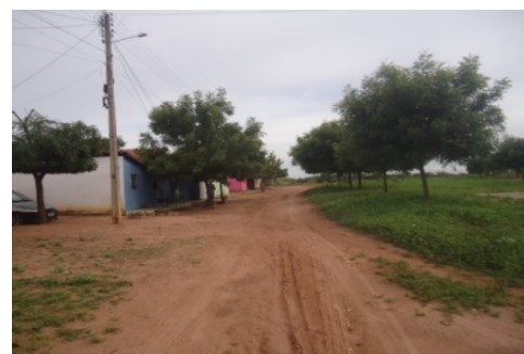
TRECHO DA PAVIMENTAÇÃO
