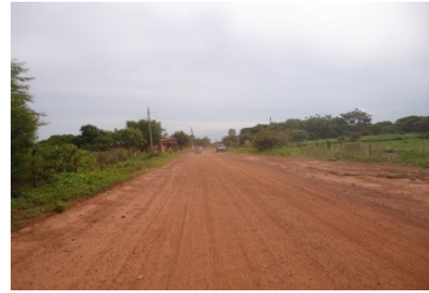
TRECHO DA PAVIMENTAÇÃO
