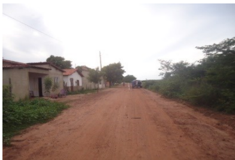
TRECHO DA PAVIMENTAÇÃO
