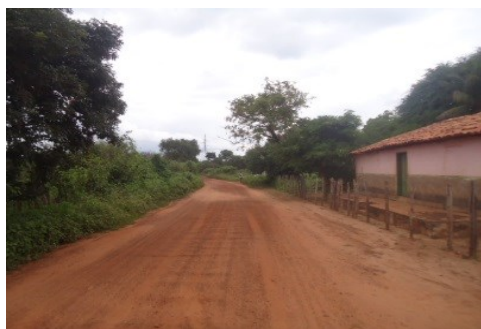
TRECHO DA PAVIMENTAÇÃO
