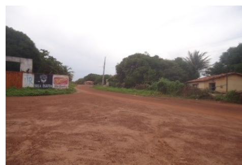
TRECHO DA PAVIMENTAÇÃO
