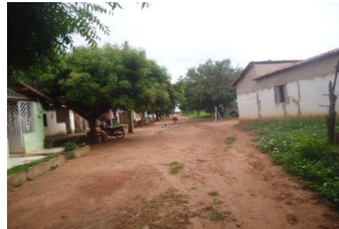
TRECHO DA PAVIMENTAÇÃO
