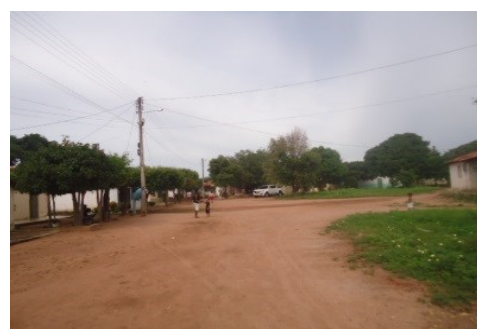
TRECHO DA PAVIMENTAÇÃO
