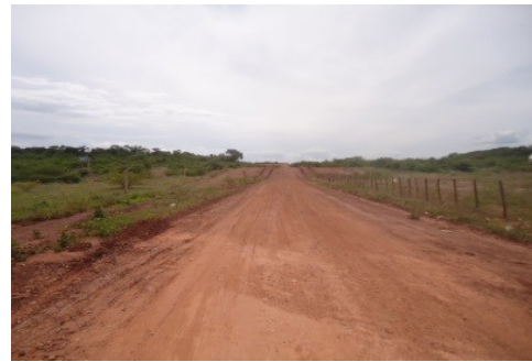
TRECHO DA PAVIMENTAÇÃO
