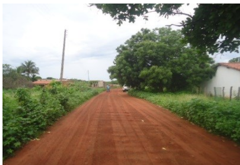
TRECHO DA PAVIMENTAÇÃO
