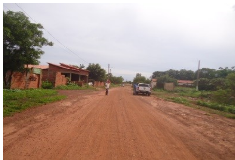
TRECHO DA PAVIMENTAÇÃO
