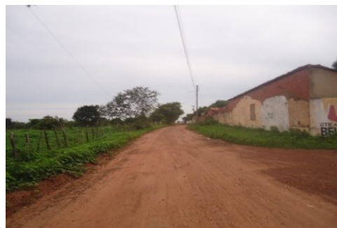
TRECHO DA PAVIMENTAÇÃO
