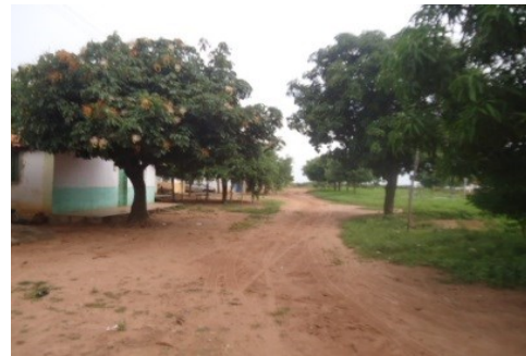
TRECHO DA PAVIMENTAÇÃO
