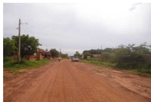
TRECHO DA PAVIMENTAÇÃO
