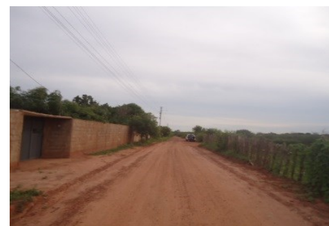
TRECHO DA PAVIMENTAÇÃO
