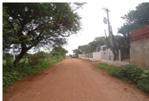
TRECHO DA PAVIMENTAÇÃO
