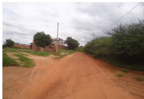
TRECHO DA PAVIMENTAÇÃO
