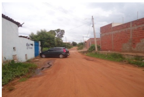
TRECHO DA PAVIMENTAÇÃO
