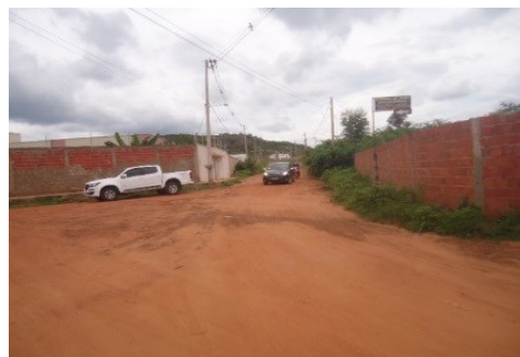
TRECHO DA PAVIMENTAÇÃO
