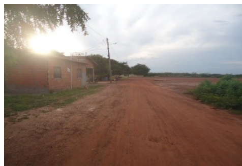
TRECHO DA PAVIMENTAÇÃO
