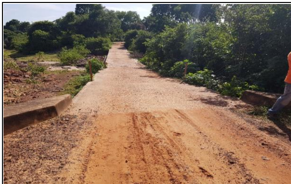
FOTO Nº 02 - PASSAGEM MOLHADA EXISTENTE (4,00 x 6,00)m - E68
