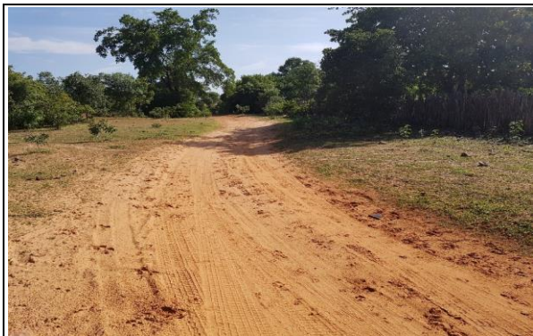
FOTO Nº 01 - INÍCIO DO SUB-TRECHO 10.1: LOC. BURITI DO REI
