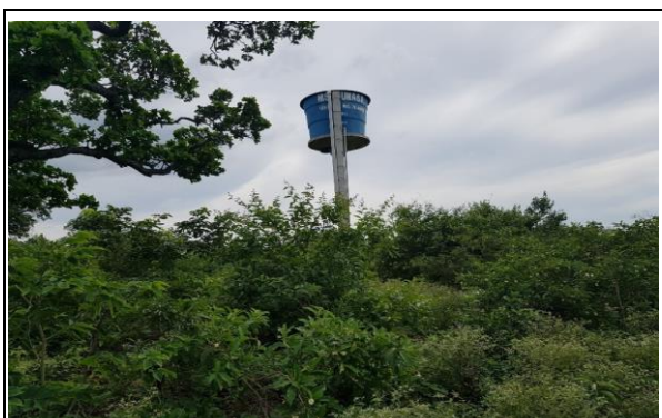
FOTO Nº 11 - FONTE DE ÁGUA 03 - E754 - Dist. Fixa = 10m
