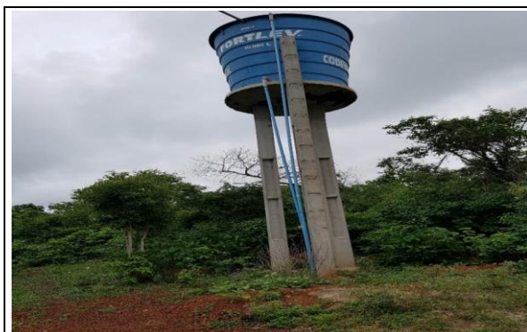
FOTO Nº 02 - FONTE DE ÁGUA 01 - E61 - Dist. Fixa = 120m
