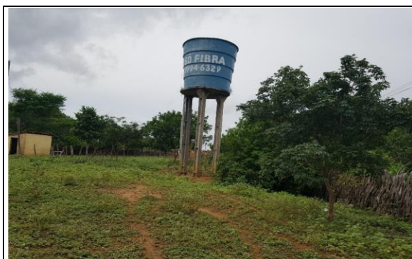
FOTO Nº 06 - FONTE DE ÁGUA 02 - E431 - Dist. Fixa = 10m
