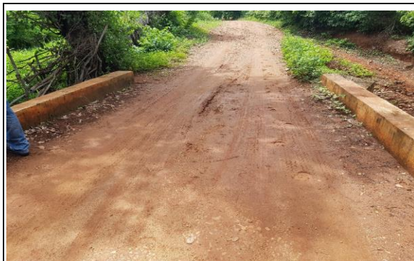
FOTO Nº 08 - PONTE EXISTENTE - E529
