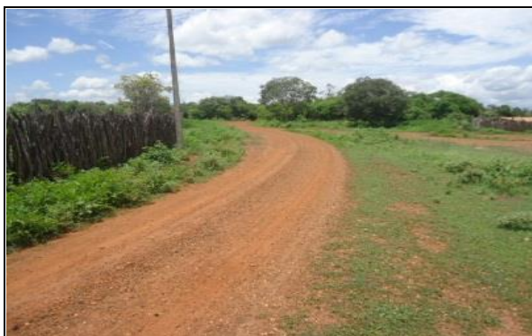
FOTO Nº 04 - SUB-TRECHO 3.1: LOC. MACHADO
