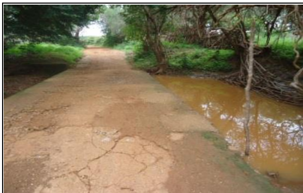
FOTO Nº 04 - PASSAGEM MOLHADA EXISTENTE 01 - E194
