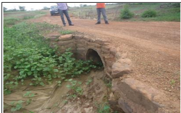
FOTO Nº 09 - BUEIRO EXISTENTE 01 - BSTC D=0,80m - E1203
