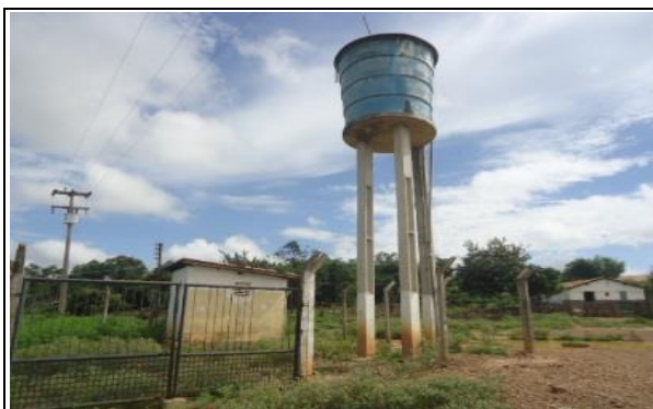
FOTO Nº 03 - FONTE DE ÁGUA 01 - FONTE DE ÁGUA 02 DO TRECHO 03 - Dist. Fixa = 1.290m
