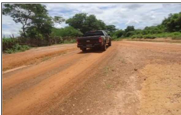
FOTO Nº 06 - FIM DO SUB-TRECHO 3.1: LOC. MACHADO
