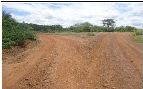
FOTO Nº 01 - INÍCIO DO SUB-TRECHO 3.1: LOC. MACHADO
