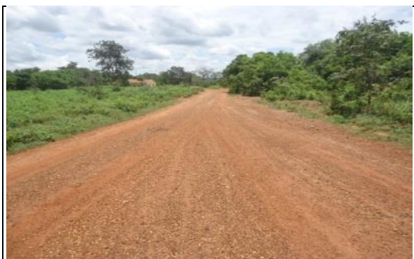
FOTO Nº 05 - SUB-TRECHO 3.1: LOC. MACHADO
