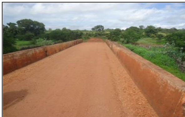
FOTO Nº 08 - PONTE EXISTENTE - E947
