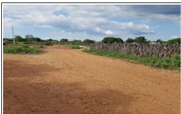
FOTO Nº 06 - FIM DO TRECHO 04: LOC. CURRAL VELHO / LOC. NOVA FAZENDA ATÉ LOC. CORUMBA (FAZENDA NOVA)
