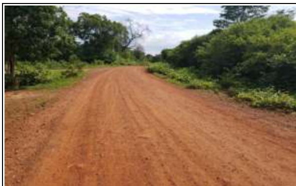
FOTO Nº 04 - SUB-TRECHO 1.2: LOC. SÍTIO
