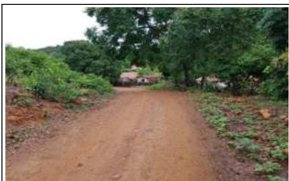
FOTO Nº 05 - SUB-TRECHO 1.1: LOC. BURITI DO CANTO
