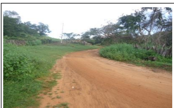
FOTO Nº 05 - SUB-TRECHO 2.1: LOC. MORRO DO CLARO
