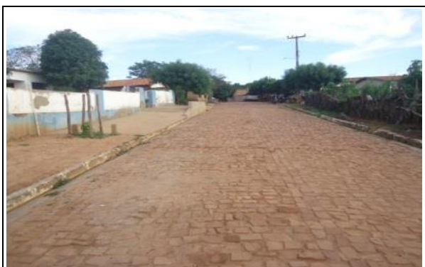
FOTO Nº 05 - TRECHO DE CALÇAMENTO EXISTENTE - E407+10,00 ATÉ E419+10,00
