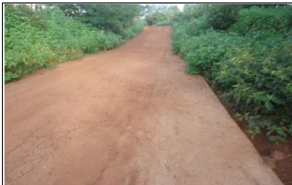
FOTO Nº 08 - PASSAGEM MOLHADA EXISTENTE 02 - E427
