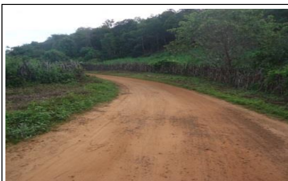
FOTO Nº 04 - SUB-TRECHO 2.1: LOC. MORRO DO CLARO
