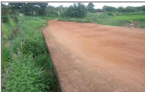
FOTO Nº 04 - PASSAGEM MOLHADA EXISTENTE 01 - E391
