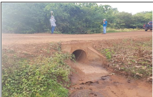
FOTO Nº 13 - BUEIRO EXISTENTE 07 - BSTD D=800mm - E302
