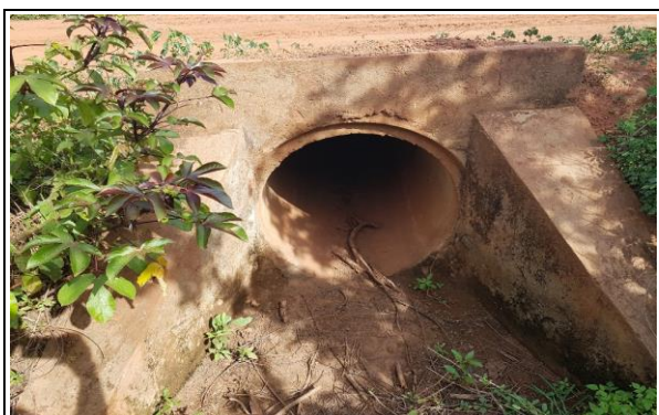
FOTO Nº 05 - BUEIRO EXISTENTE 04 - BSTC D=800mm - E99
