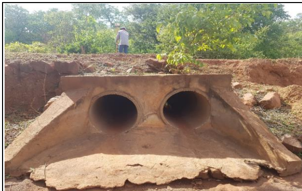
FOTO Nº 02 - BUEIRO EXISTENTE 01 - BDTC D=800mm - E17
