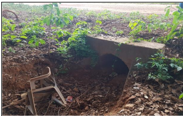
FOTO Nº 10 - BUEIRO EXISTENTE 06 - BSTC D=800mm - E1205
