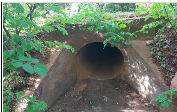
FOTO Nº 04 - BUEIRO EXISTENTE 03 - BSTC D=800mm - E66
