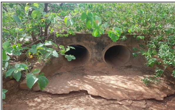
FOTO Nº 03 - BUEIRO EXISTENTE 02 - BDTC D=800mm - E43
