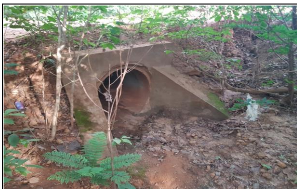
FOTO Nº 14 - BUEIRO EXISTENTE 08 - BSTD D=800mm - E318
