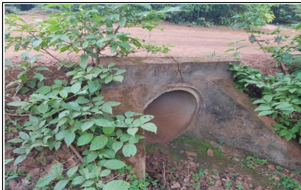
FOTO Nº 08 - BUEIRO EXISTENTE 05 - BSTC D=800mm - E131
