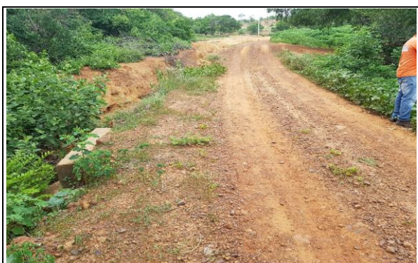
FOTO Nº 17 - BUEIRO EXISTENTE - BSTC D=1,00m - E228
